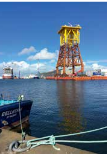
Sous-station électrique construite à Saint-Nazaire (2018). © A. Kloss/SWAT.
