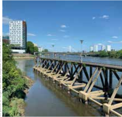
Le ponton à l'angle des quais Magellan et Ferdinand Favre
